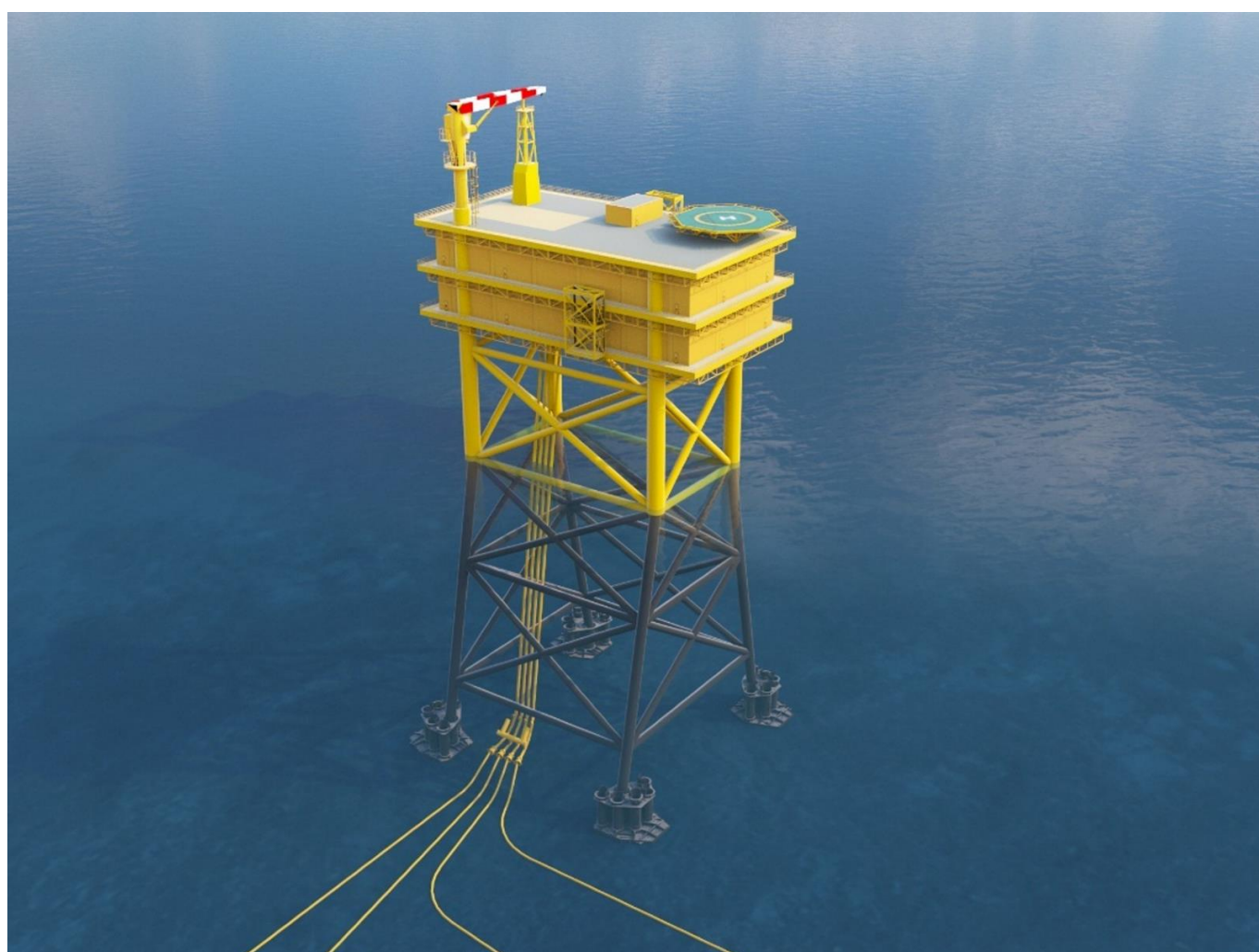
Joonis 6. Avamere alajaama ja selle sõrestikvundamendi illustratsioon
